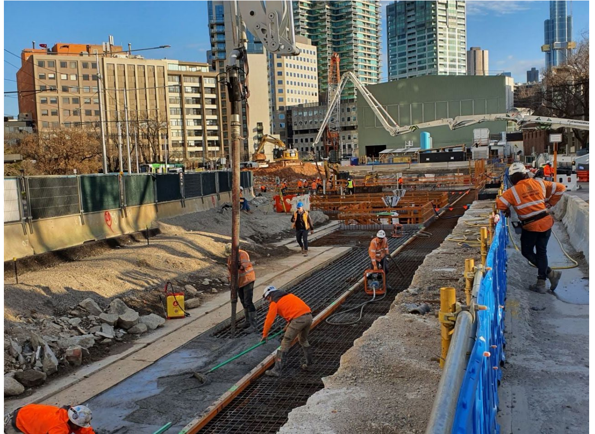
Middle box roof slab pour one
