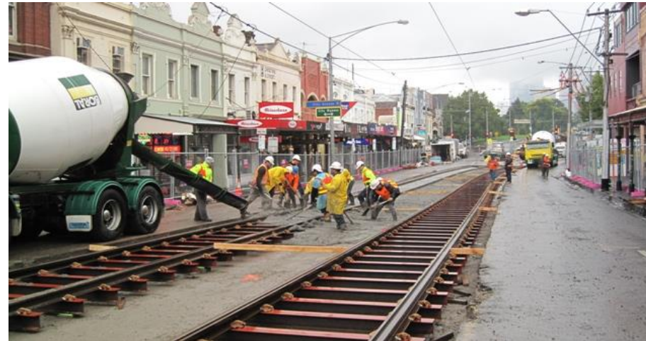
4. Concrete pouring commences
