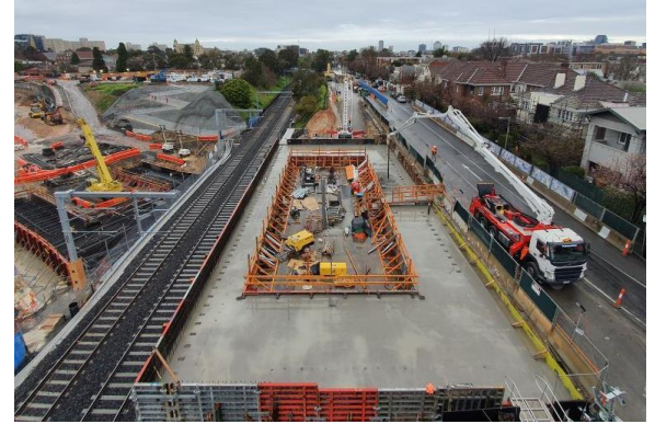
Roof slab concrete pour
